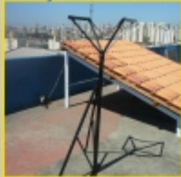
SUPOORTE TIPO TRIPÉ instalação de reservatório
